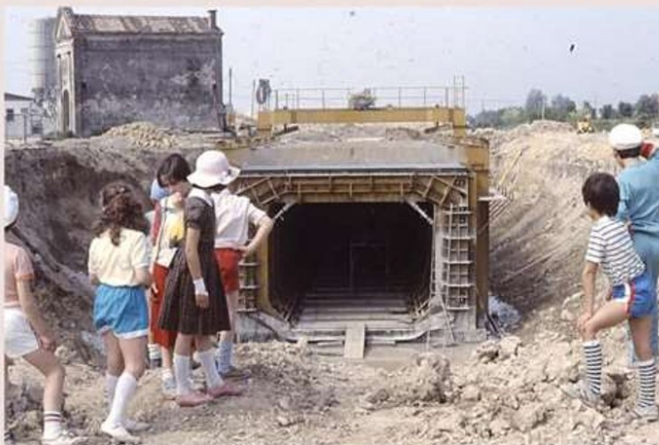
E LA COSTRUZIONE DEL CANALE IDRICO LEB NEL 1984
