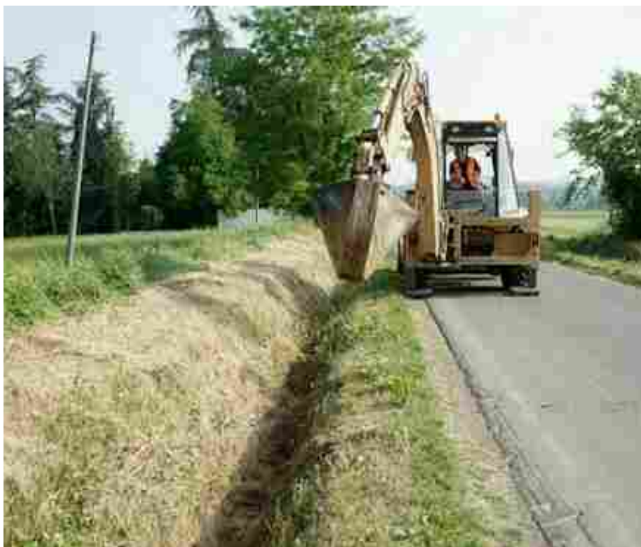
Manutenzione e pulizia dei fossi stradali deputati al drenaggio e alla raccolta delle acque piovane
