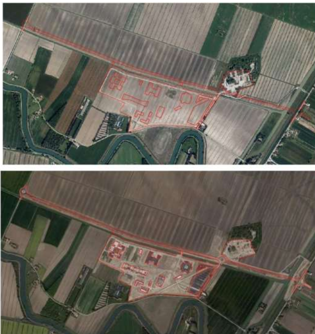
Fig. 1.6: Realizzazione di un nuovo campus a Roncade (Treviso) su un'area di cantiere di 35 ettari, ex area agricola, di cui 5,2 ha destinati a nuova viabilità, 2 ha a parcheggio e più di 3 ha destinati a costruzioni con cubatura recuperata da una ex area militare limitrofa di 2,27 ha (in alto a destra). Immagine 2018 in alto, 2020 in basso.
