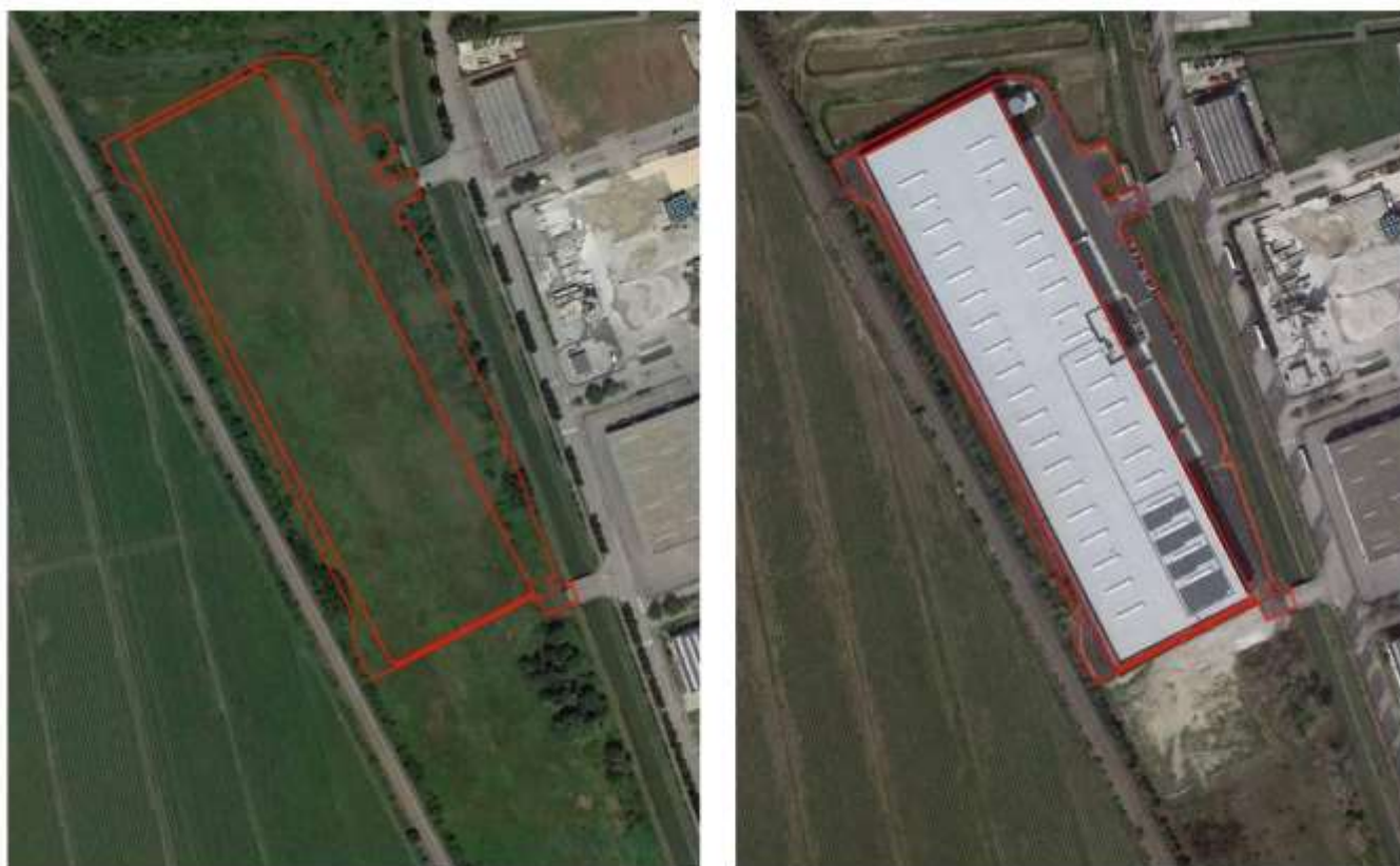
Fig. 3.14: Centro logistico di una multinazionale francese a Vescovana (PD) di nuova realizzazione su un'area di 53.400 m 2 , di cui 37.300 m 2 consumati per la realizzazione dell'edificio e 16.100 m 2 occupati da aree impermeabilizzate per consentire l'accesso dei mezzi e per la realizzazione di aree adibite a parcheggio (immagine 2018 a sinistra, 2020 a destra).
