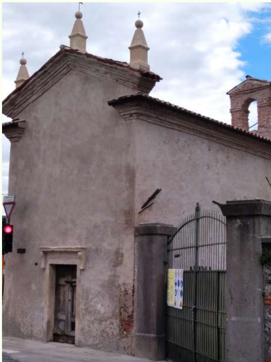
La chiesetta di San Carlo a Monteforte in fase di ristrutturazione: ripulita e dignitosa
