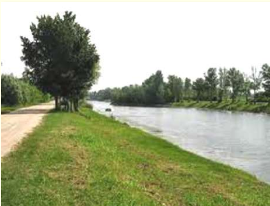
Stato attuale dell'idrovia Padova-Venezia mare (10 km su 27 scavati)
