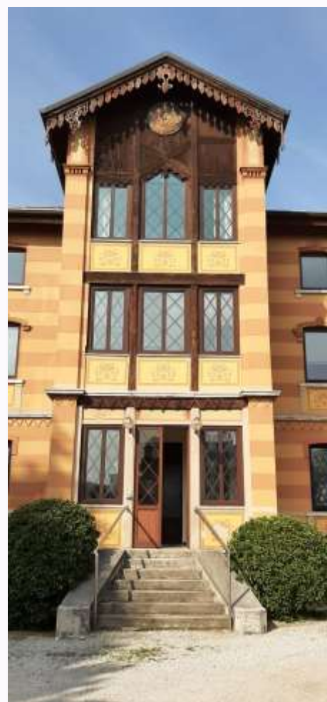
Lanificio Ferrarin. Uffici storici
