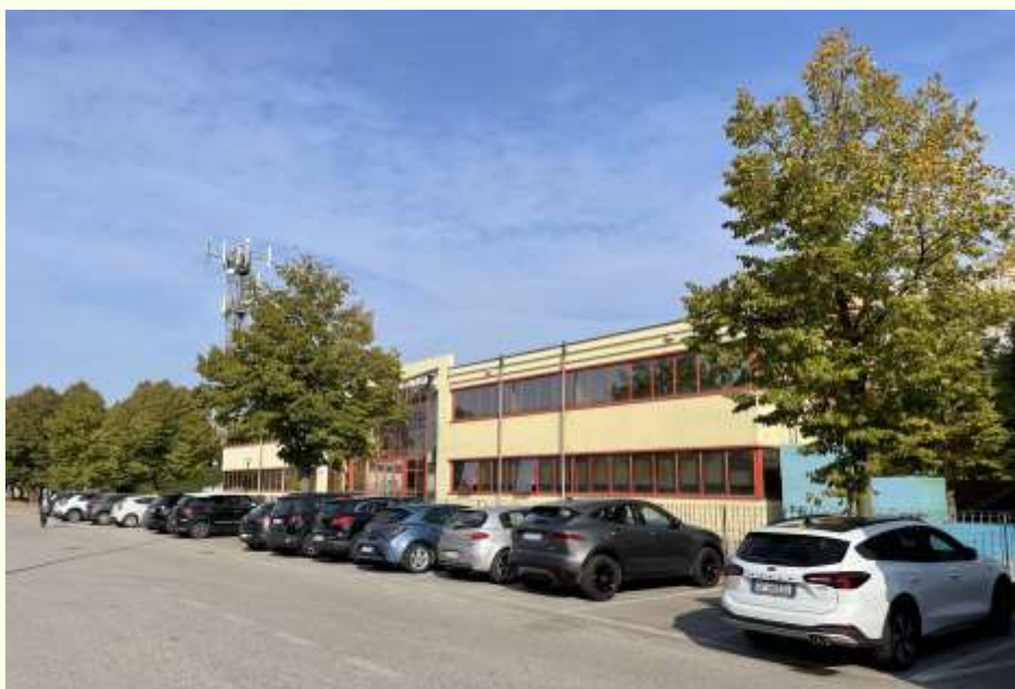
Edificio inutilizzato a Borgoricco che diventerà un asilo nido interaziendale
