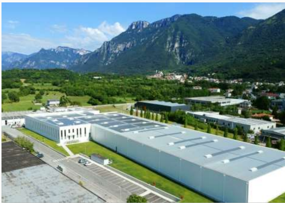
Magazzino stagionatura dei formaggi a Cogollo del Cengio
