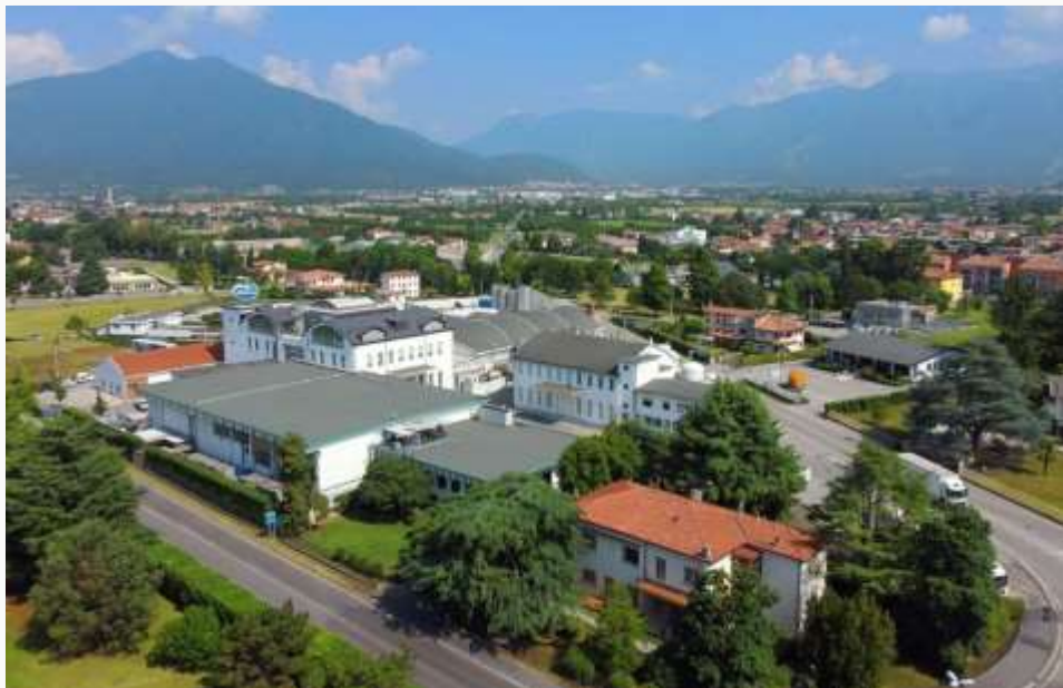
Stabilimento produttivo Brazzale a Zanè
