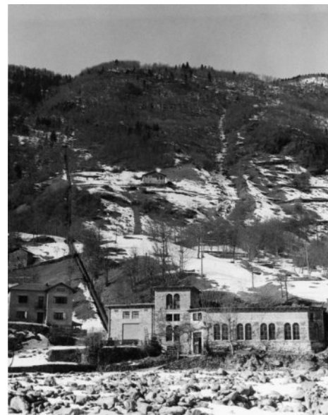
Centrale idroelettrica di Enfretors entrata in funzione nel 1933
