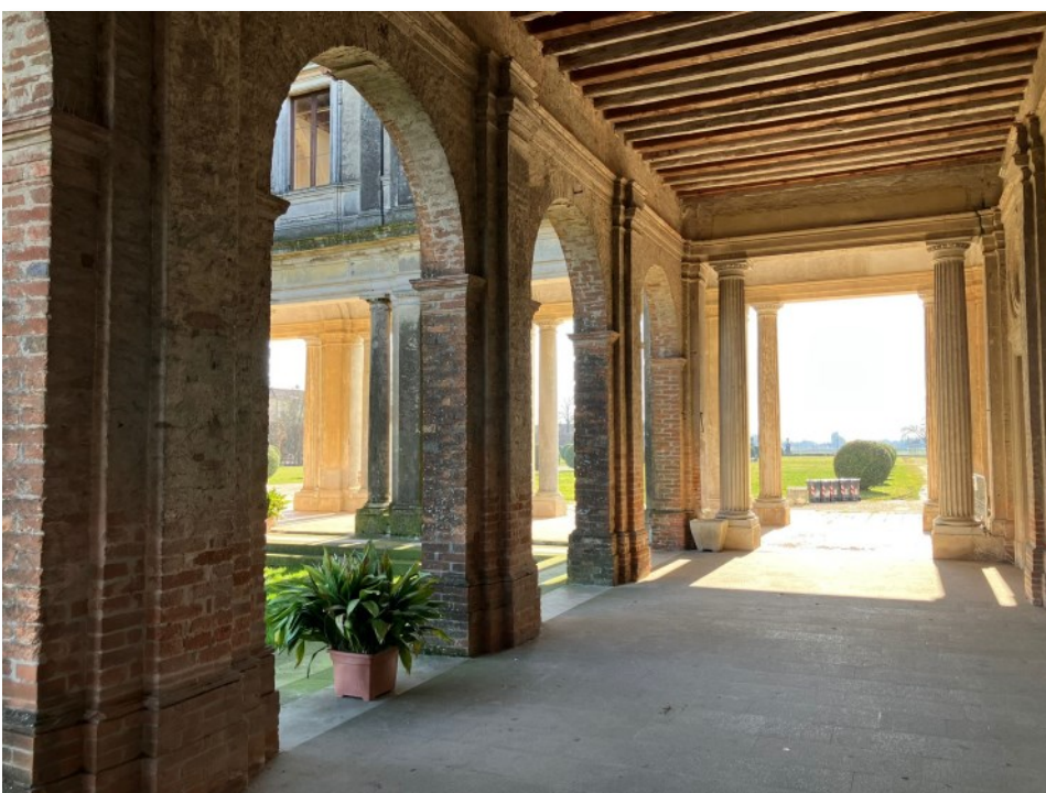
Il portico Barchessa ed entrata della villa
