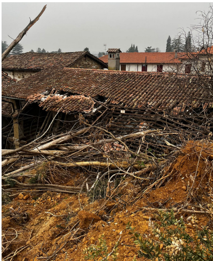
Danni dopo l'alluvione del 2025 a Versa (foto L. Gaetani)
